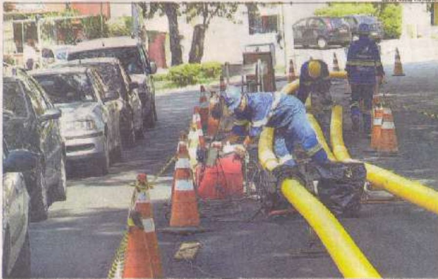
Operários instalam encanamento de gás natural na Rua General Osório; trânsito fica complicado em todo o bairro
