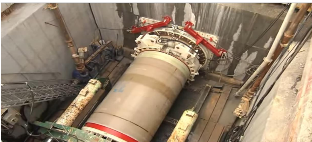
Снимки 3-39: Безизкопно полагане на стъклопластови тръби
