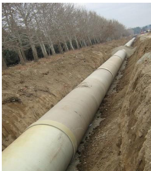
Снимки 3-31: Инсталиране на стъклопластови тръби
