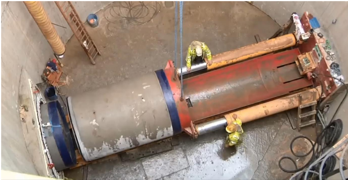
Снимки 3-38: Безизкопно полагане на бетонови тръби
