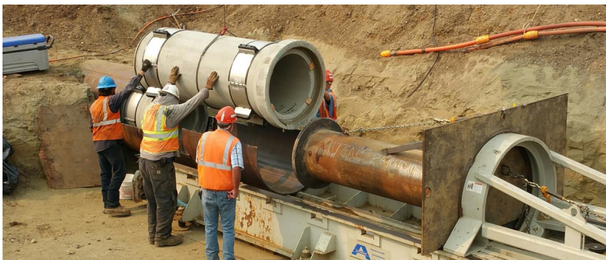
Снимки 3-41: Безтраншейно полагане на стоманобетонени тръби
