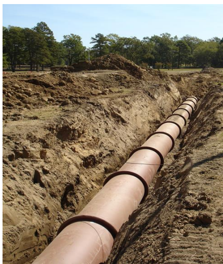
Снимки 3-32: Инсталиране на стъклокерамични тръби
