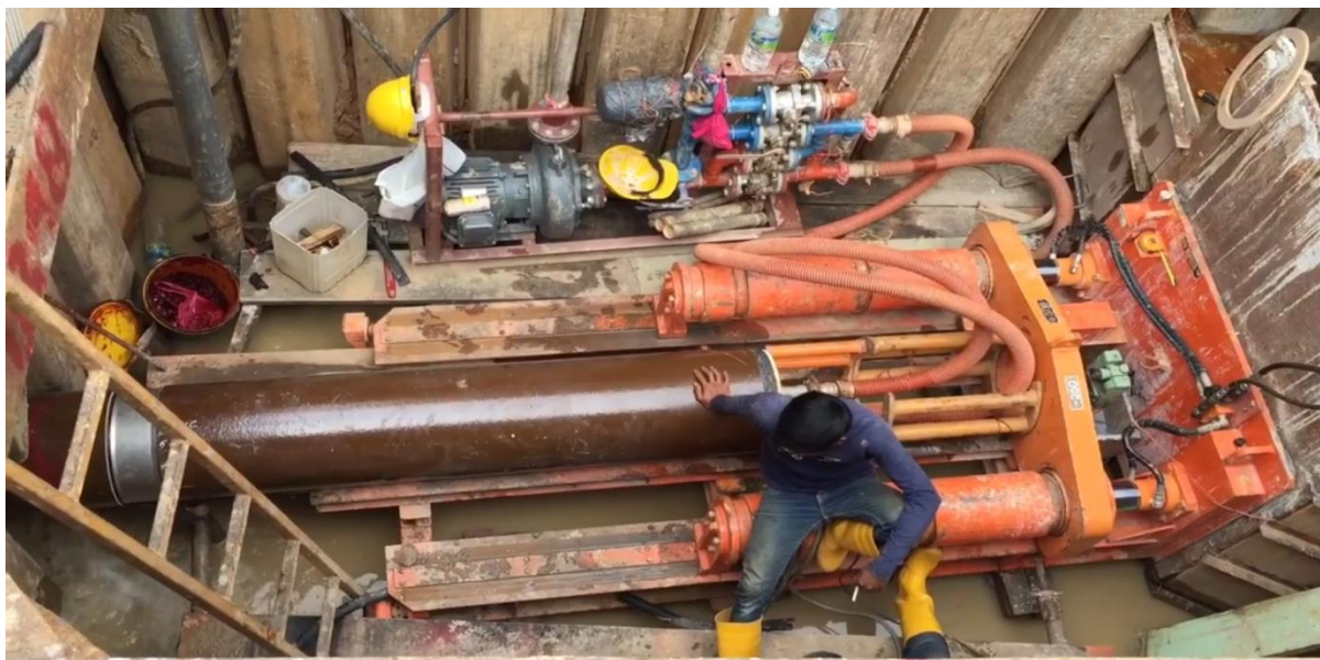
Снимки 3-40: Безизкопно полагане на стъклокерамични тръби
