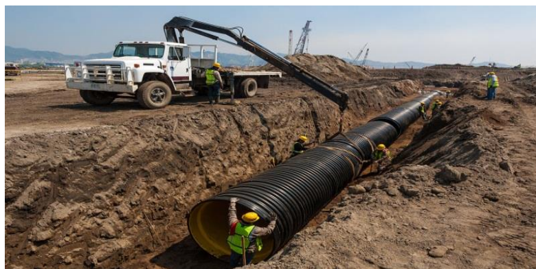
Снимки 3-30: Инсталиране на пластмасови тръби
