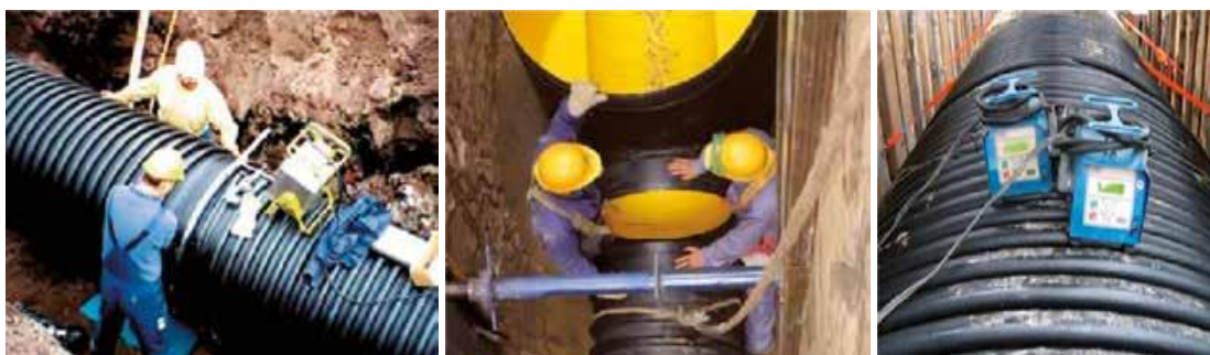
Снимки 3-11: Електрофузионното заваряване
