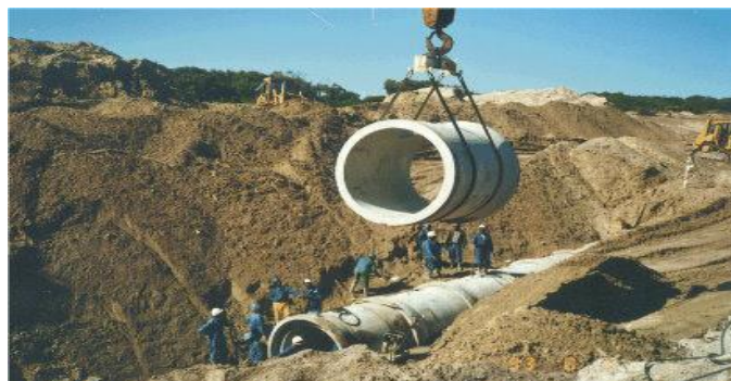
Снимки 3-29: Инсталиране на бетонни тръби
