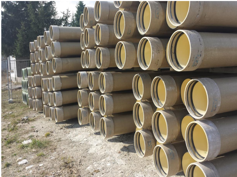
Снимки 3-23: Начин на складиране на даден пакет
